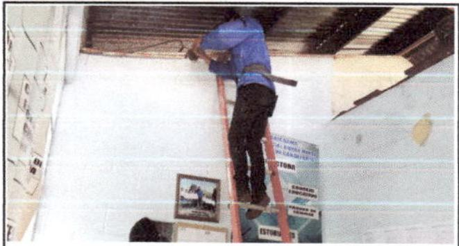
FOTO: 4 Cambio del cablado electrico.
